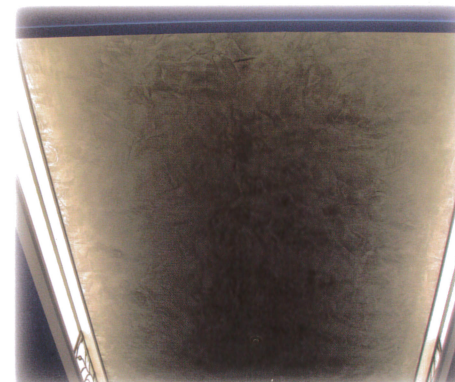
多目的ホール (企業ビル) / 折り上げ天井
