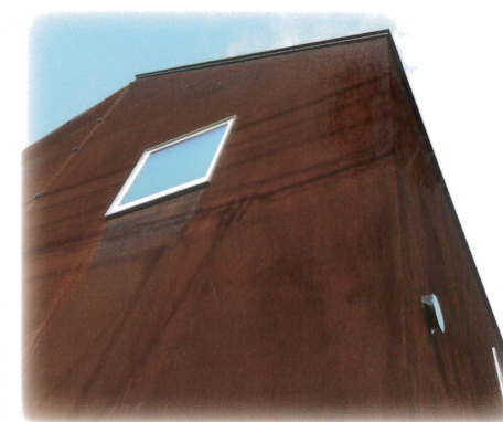
壁面 (個人住宅) / 外壁
